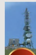
スペイン・ABERTIS TELECOM社所有のマゼラ通信塔に設置。従来は電気・電子部品の損傷を伴う落雷が多発していましたが、dinnteco-100plus設置後は、周辺3km圏内で374回の落雷が発生する中、保護範囲(半径100m)内への落雷は0件という結果となりました。
