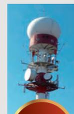
スペイン気象庁の気象レーダーに設置。バスク地方は雷の発生率が高い地域として知られています。dinnteco-100plus設置直前にはレーダーへの直撃雷があり、実証実験期間中も2km圏内で96回の落雷がありました。保護範囲内への落雷は、冬季雷を含め0件となりました。
